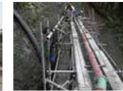
水道施設工事
